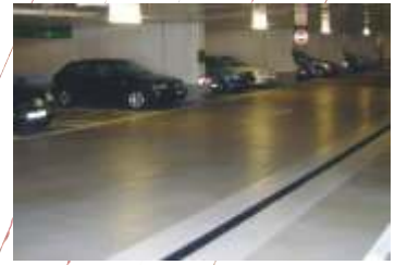
Nachträgliche Abdichtung einer Ablaufrinne bei einem EP-Belag.
