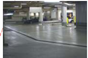
Beschichtung mit EP-Belag.
