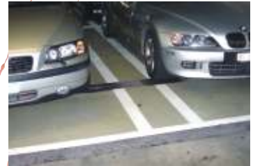
Abdichtung der Bewegungsfugen mit THORMA-FLEX.
