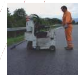
Schneiden der Fugen im Trockenschnittverfahren mit Absaugung.
