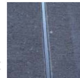
In zwei Arbeitsgängen verfüllte Kontraktionsfuge.
