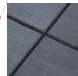
Vorbereitete Kontraktionsfuge bei einer neu erstellten Beton-Verkehrsfläche.
