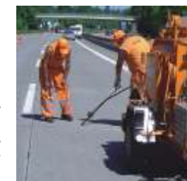
Sorgfältiger Heissverguss mit Pumpkocher und Lanze bei konstanter Temperatur.
