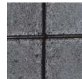
Fertig vorbereitete Kontraktionsfuge bei einer Instandsetzungs-massnahme.
