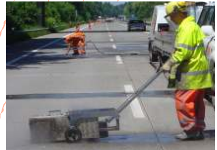
Individuelles ausbrechen und reinigen von Betonfugen mit Roboter.
