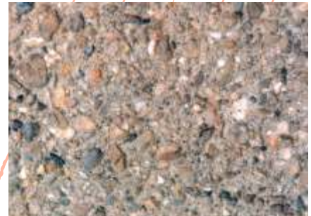
Reinigen und Aufrauen von Oberflächen.
