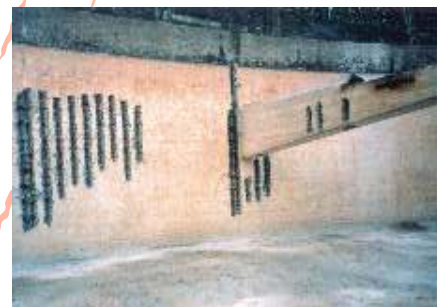
Betonabtrag sowie freilegen der Bewehrungen.
