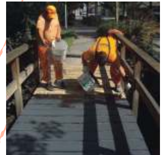
Auftragen des Beschichtungsmaterials auf dem sauberen Untergrund.
