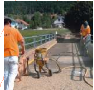
Vorbereiten des Objektes im Sandstrahlverfahren.
