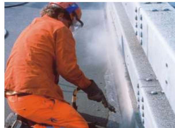
Reinigung der THORMA-FLEX-Fuge
