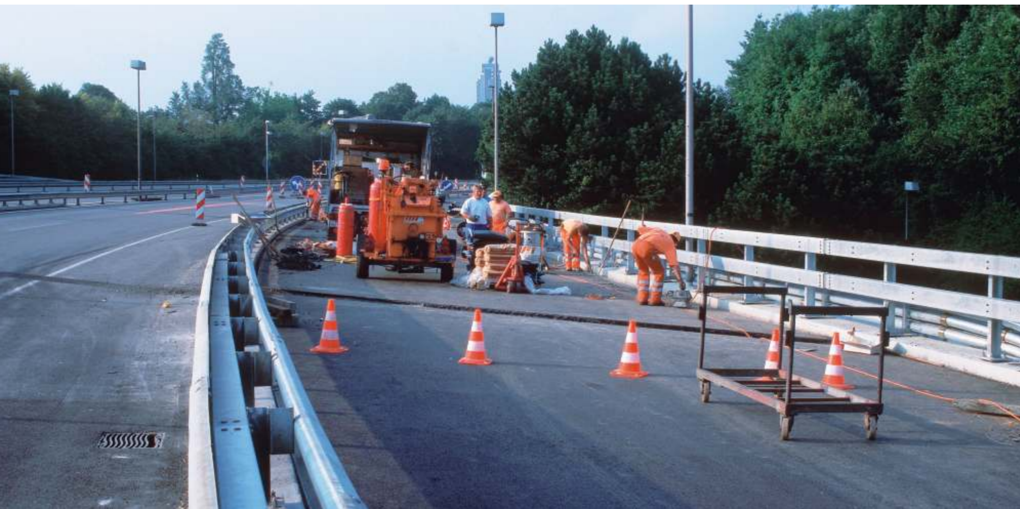
Ausgeklügelt und seit über zehn Jahren in der Praxis erprobt, garantiert das THORMA-JOINT-System dauerhafte Belagsübergänge ohne Schwellenbildung. Das System erfüllt alle Anforderungen der ASTRA-Richtlinie für Fahrbahnübergänge aus Polymerbitumen (1998).
