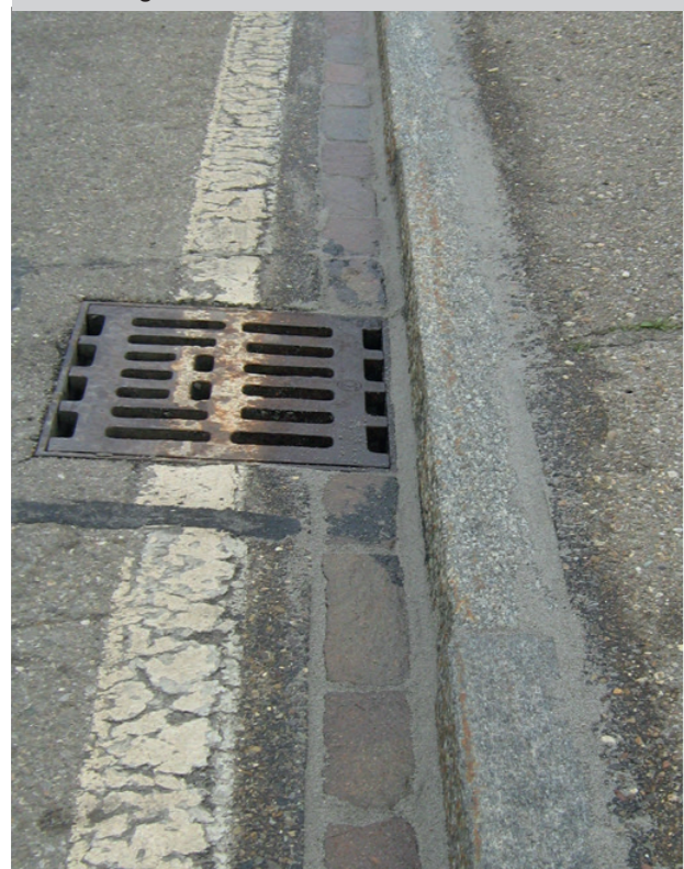
Zustand: RESA-Bord classic nach Vergussarbeiten
