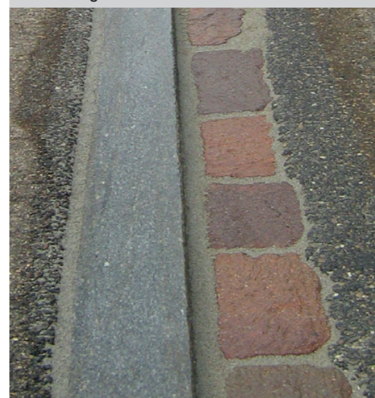
Zustand: RESA-Bord mittel nach Vergussarbeiten
