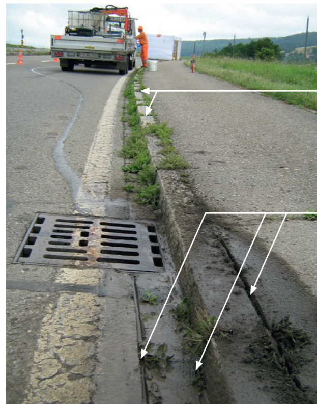
Zustand: RESA-Bord classic nach Vergussarbeiten
