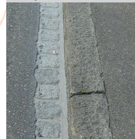
Zustand: RESA-Bord light nach Vergussarbeiten
