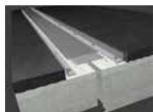
Verlegen der Trennmatte auf Einlegeplatte
