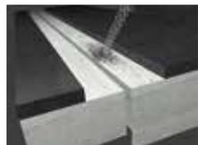
Die Fugenmulde wird mittels Sandstrahl gereinigt.
