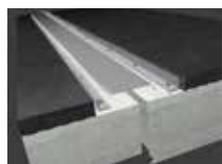
Positionierung der Einlegeplatte über Dilatationsspalt
