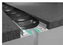
Die bituminöse Vergussmasse wird schichtweise eingebaut.
