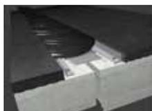
remplissage du joint avec du polymère haute performance (HLP)
