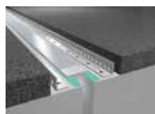
pose de la natte de séparation
