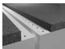
La réservation du joint est soigneusement creusée ou évidée dans le béton.
