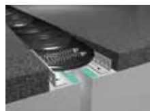
installation du polymère haute performance (HLP)
