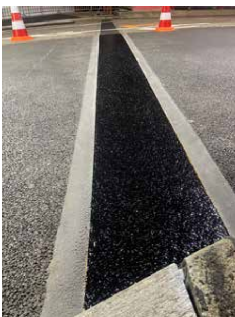
La réservation du joint est soigneusement creusée ou évidée dans le béton.
