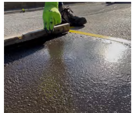
Abziehen von austropox® SR9
