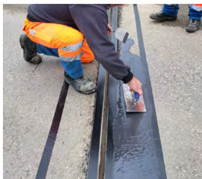
Verarbeitung austropox® SR9
