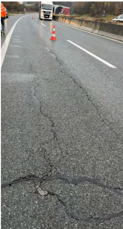
Unebenheiten durch Setzungen
