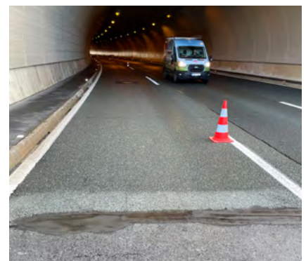
Sanierung mit austropox® SR9
