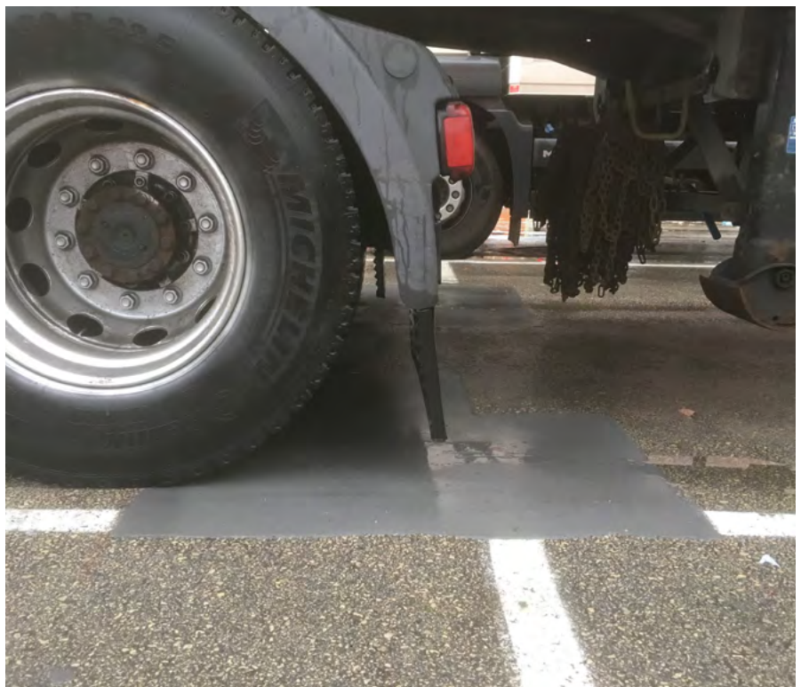
Sanierung mit austropox® SR9
