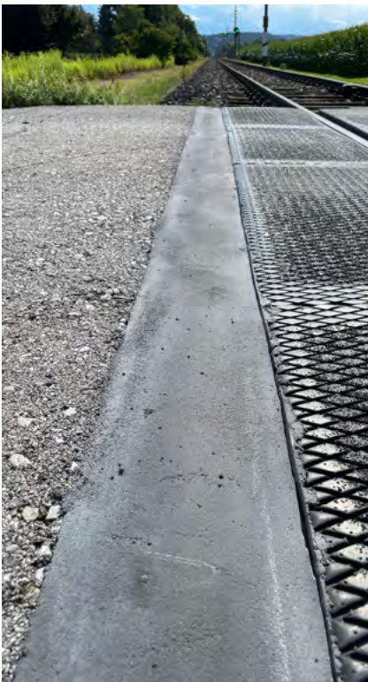
Sanierung mit austropox® SR9
