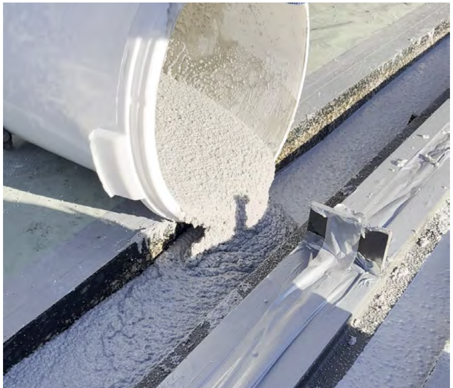
Verguss des Anschlussbereiches mit austropox® SR9
