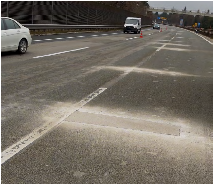
ASFINAG-Tagesbaustelle mit einer Sperrzeit von 09.00 bis 15.00 Uhr
