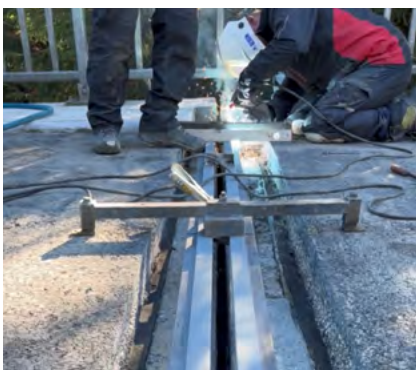
Verschweißung der Konstruktion
