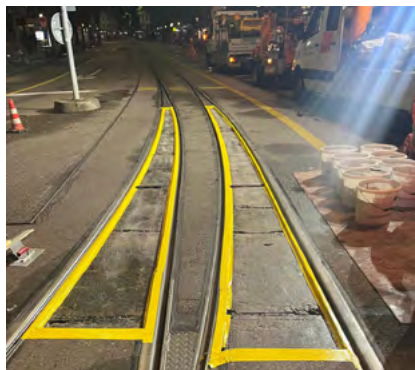
Beschädigte Gleisplatten/Gleiszwinkel
