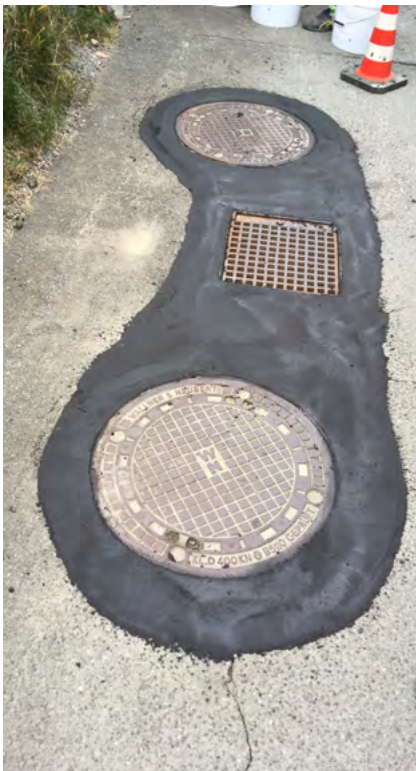
Angleichung mit austropox® SR9
