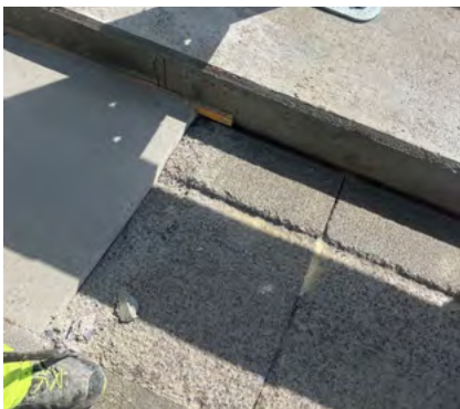
Einbau austropox® SR9
