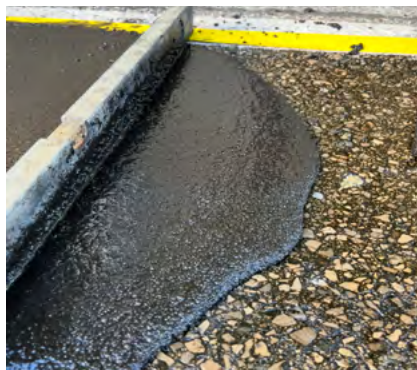
Einbau von austropox® SR9
