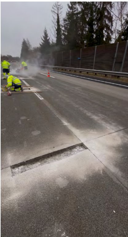
Verarbeitung bei 0°C Lufttemperatur
