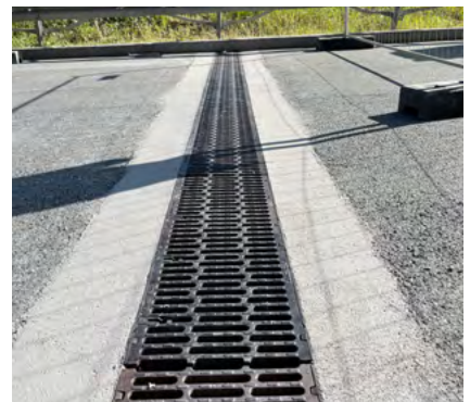
Anschlussbereich mit austropox® SR9
