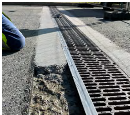
Einbau austropox® SR9
