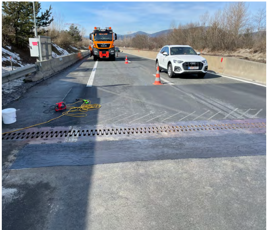
Angleichung der FÜK/ÜKO mit austropox® SR9
