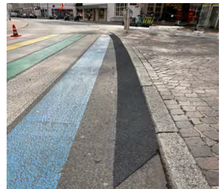
Niveauangleichung mit austropox® SR9
