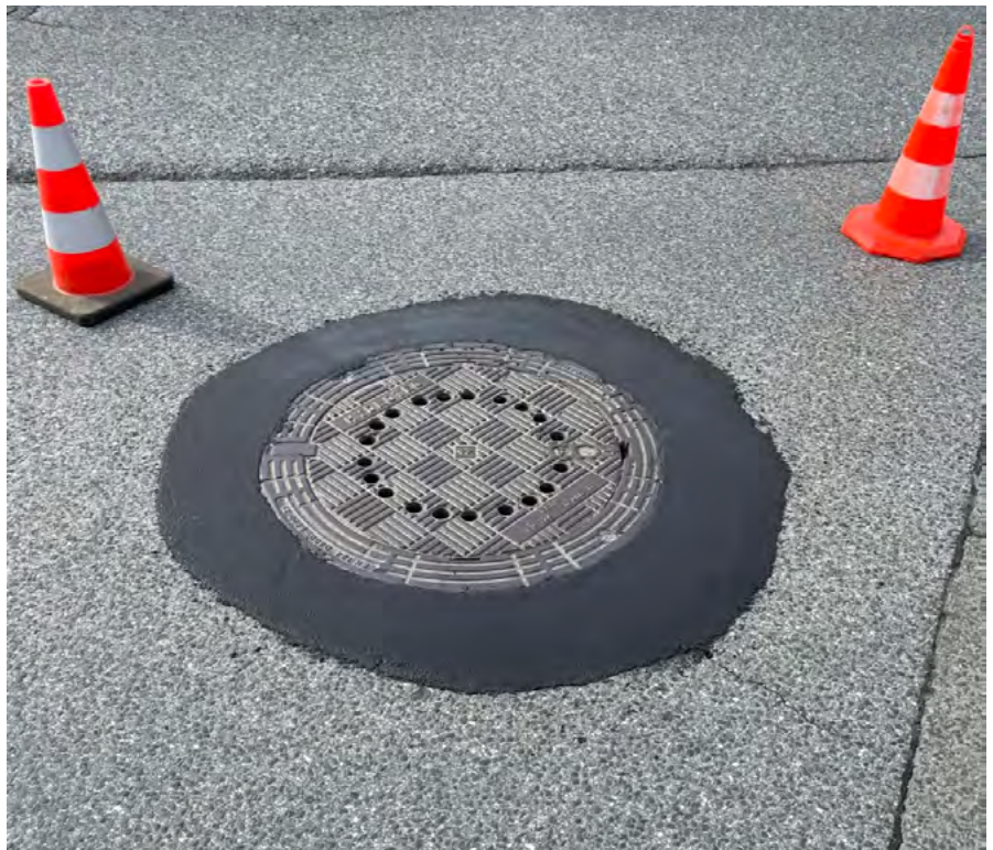
Sanierung des überstehenden Kanalschachtes mit austropox® SR9
