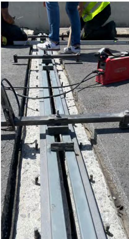
Höhenausrichtung der Konstruktion
