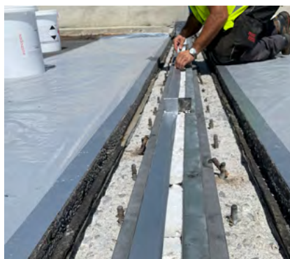
Vorbereitungen für den Verguss
