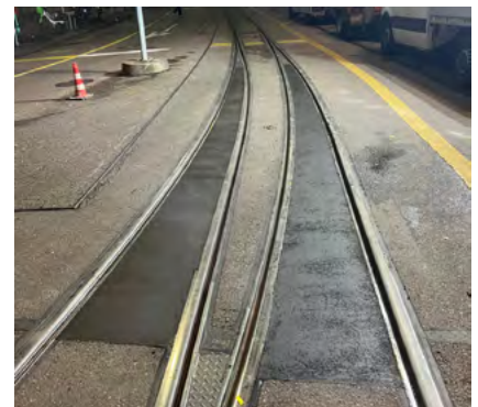
Sanierung mit austropox® SR9
