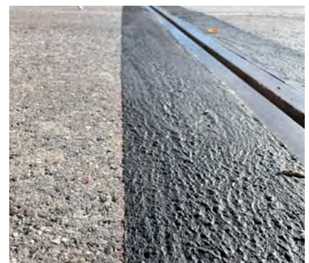
Höhengerechter Belagsanschluss
