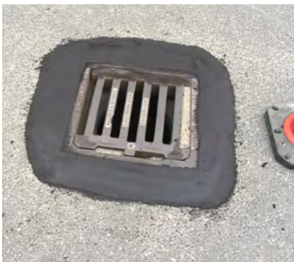
Einlaufgitter mit austropox® SR9
