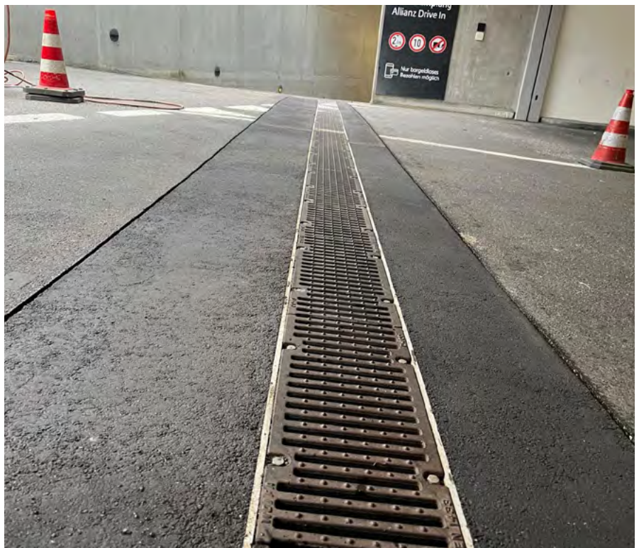
Vermörtelung der hochbelasteten Entwässerungsrinne mit austropox® SR9
