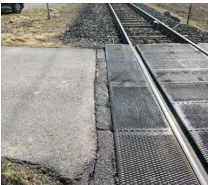
Mangelhafter Anschlussbereich
