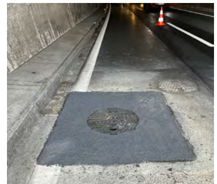
Sanierung mit austropox® SR9
