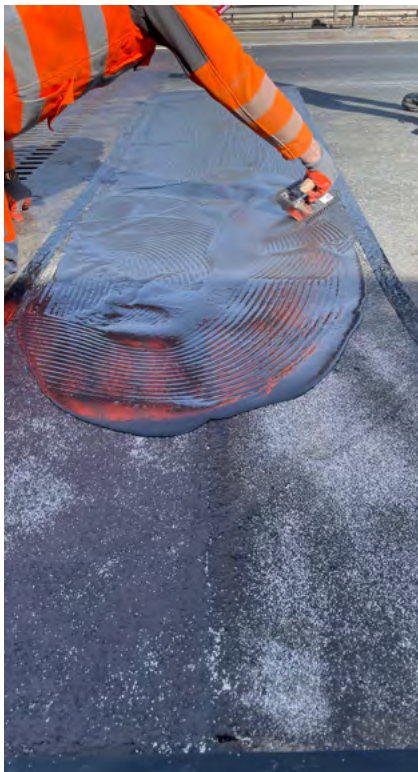
Verarbeitung austropox® SR9
