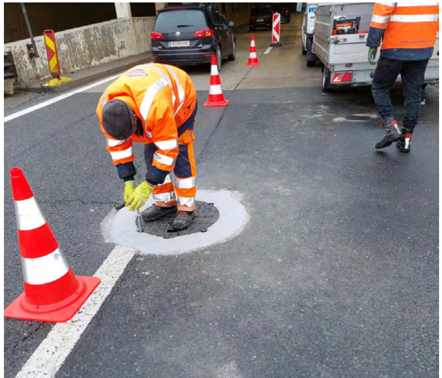
Verkehrsfreigabe ca. 60 Minuten nach dem Einbau bei 0°C
